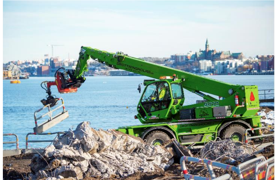
Elhybridmaskin vid Slussenbygget. Skanska/DEAB.
